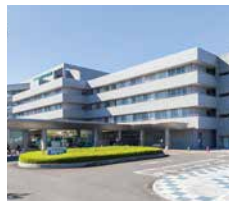
国際医療福祉大学塩谷病院 (栃木県矢板市)
